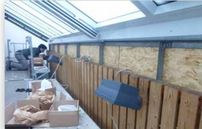
Vor dem Abbau des Innengerüsts wurden die Verdunklungsrollos der Oberlichter und die neuen LED-Strahler montiert, sowie die innen sichtbaren Stahlträger lichtgrau lackiert.
