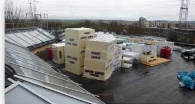
Anschließend wurde die Dachabdichtung angebracht und die Gefälledämmung mit dem Kran aufs Dach gehoben.
